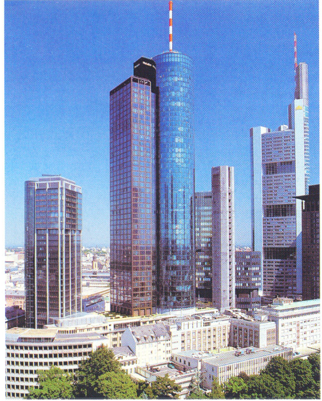
الشكل (1): يوضّح منظر عام لمبنى " Main Tower " في مدينة ماين، فرانكفورت. [1,9]
