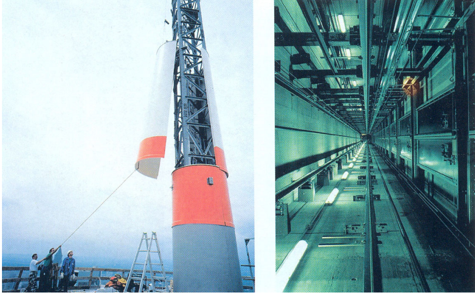
الشكل (5): يوضّح بئر المصعد في مبنى "Main Tower"، وتركيب هوائي أستوديو المحطة الإذاعية (HR). [1,9]
