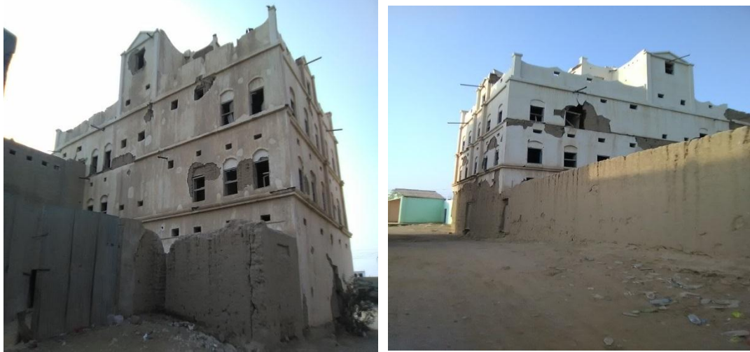
صورة (13): آثار التقشر على جدران المبنى، تصوير الباحث عام 2022م.
